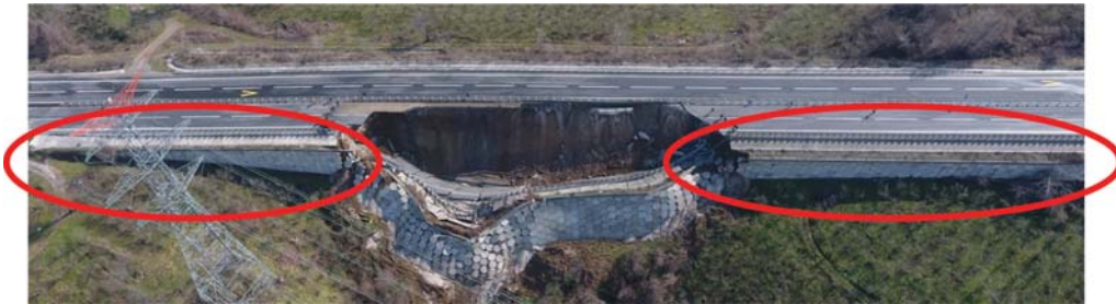
Şekil 4 - Göçme bölgesinin kuzey ve güney tarafında devam eden toprakarme duvar
