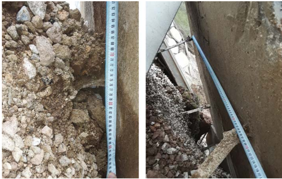
Şekil 6 - Zemin donatı şeritleri yatay ve düşey aralıkları
