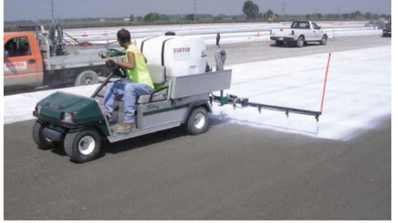
Şekil 9 - SSB yolda beyaz renkli kür kimyasalı uygulanması [1]
