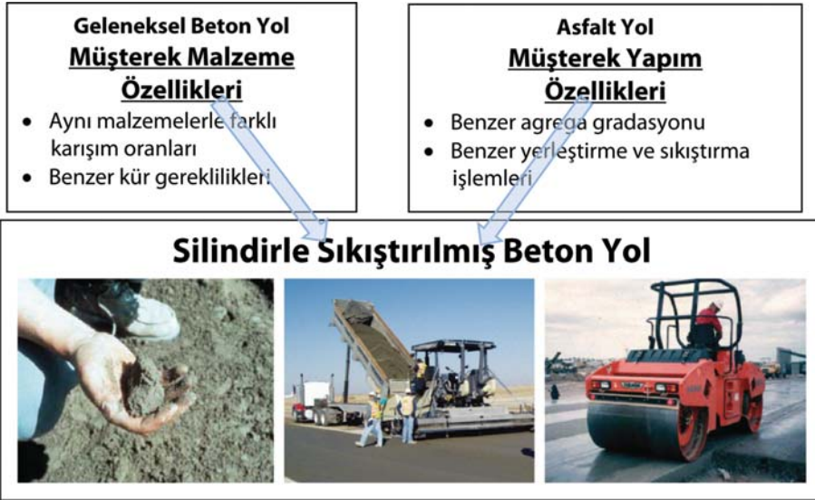
Şekil 1 - Silindire sıkıştırılmış beton yollar, geleneksel beton malzemeleri kullanılarak asfalt yol ekipmanları ile inşa edilebilirler [1].
